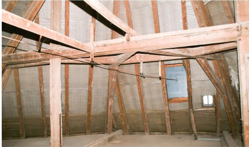
Teil der 27 m langen Transmission zwischen Uhrwerk und Zifferblatt
